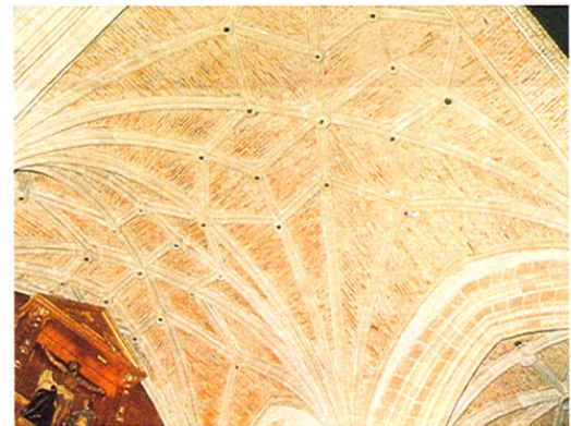
Chillón. Bóveda de crucería de la iglesia parroquial
